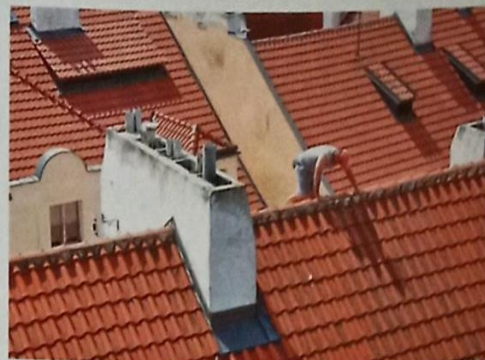
2 Dachdecker bei der Arbeit
